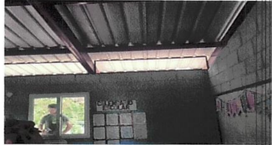
Foto 2: Instalación de marco de metal para proteger mojinete.
