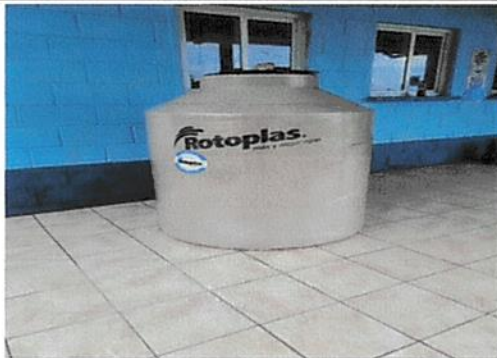
Foto 5: Instalacion de rotoplast de 1,100 litros,
