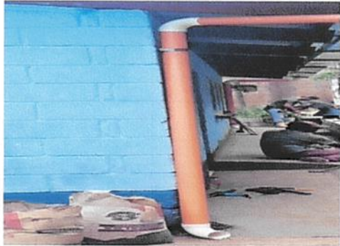
Foto1: Colocación de canales y bajadas de agua.
