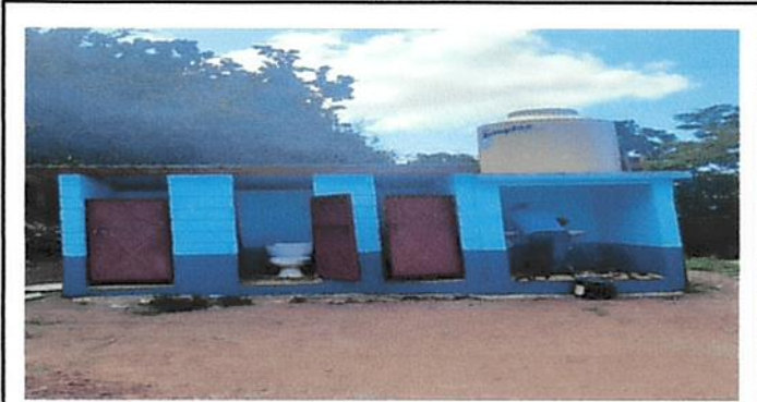
Foto 13: Restauración de pintura interior y exterior de batería de baños, reparación de puertas de baños.
