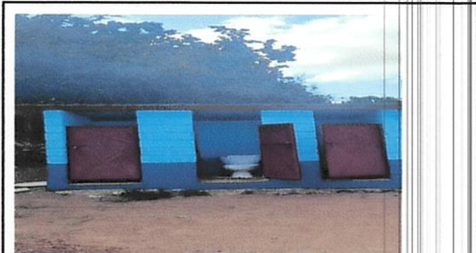
Foto 14: Reparación de sanitarios.
