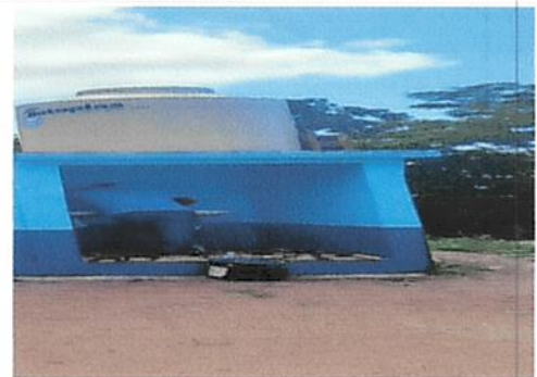
Foto 12: Mantenimiento de lavamanos
