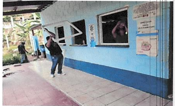
Foto 8: Instalación de ventanas de PVC.
