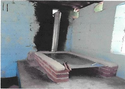
Foto 9: Mejoramiento de cocina y ampliación de polletón.
