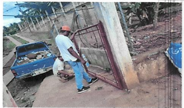
Foto 10: Reparación de portón de acceso.
