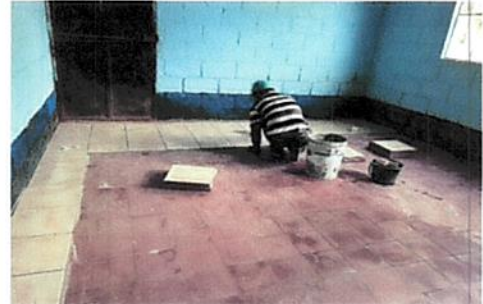
Foto 4: Instalación de piso cerámico
