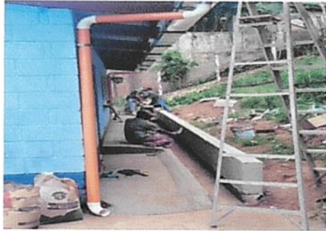
Foto 7: Restauración de cuneta de protección
