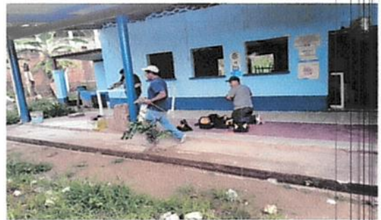
Foto 6: Pintura de interior y exterior del centro educativo.
